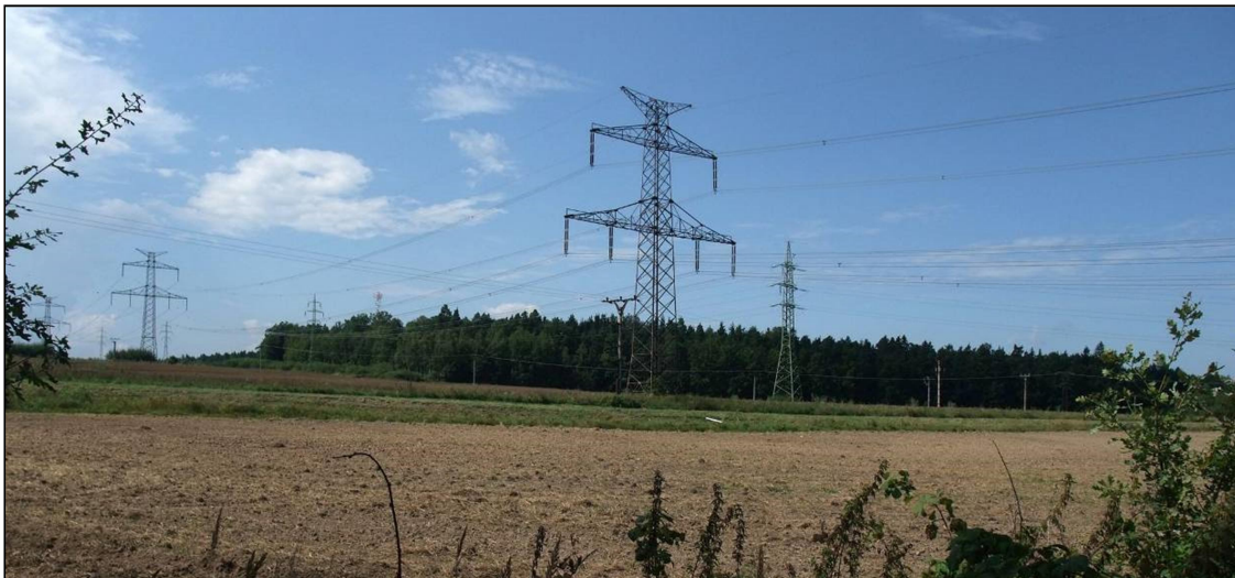
Obr. 4 Souběh vedení 2 x 400 kV (v popředí) a 2 x 110 kV - ilustrační foto
